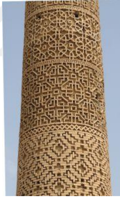
Fotoğraf 26: Damgan Cuma Camii minaresinden ayrıntı.
